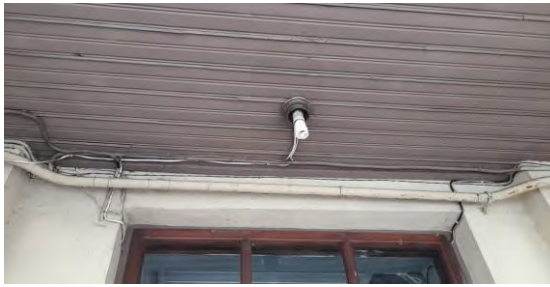
8 pav. Šviestuvai be apsauginių gaubtų. Tokius šviestuvus naudoti draudžiama, kadangi neatitinka Priešgaisrinės saugos taisyklių ir EİİBT reikalavimų.
