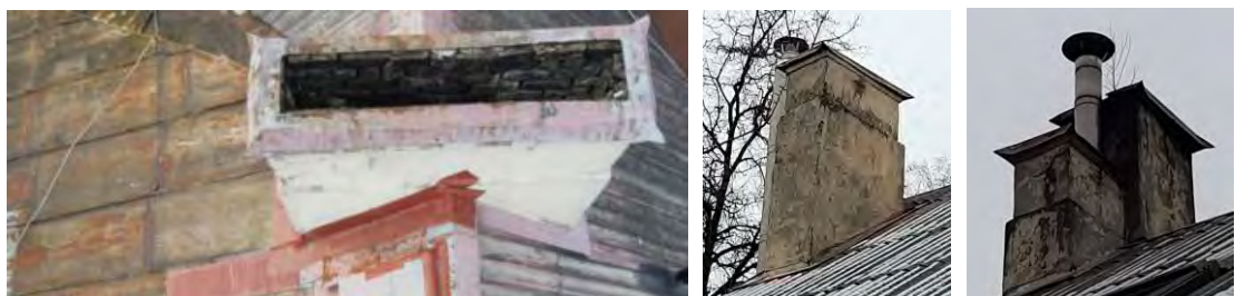
7 pav. Kaminų siūlės išplautos (iš vidaus), tinkas trupa, viršutiniai skardinimai neapsaugo mūro nuo drėgmės. Apatiniai skardinimai netinkamai suvesti su stogo danga – dėl to galimi pratekėjimai į vidaus patalpas.
