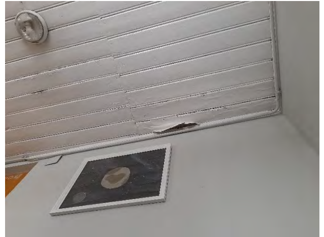
6 pav. Laiptinės vidaus apdaila atnaujinta, nuo buvusio pratekėjimo pažeistos lubų medinės dailylentės.
