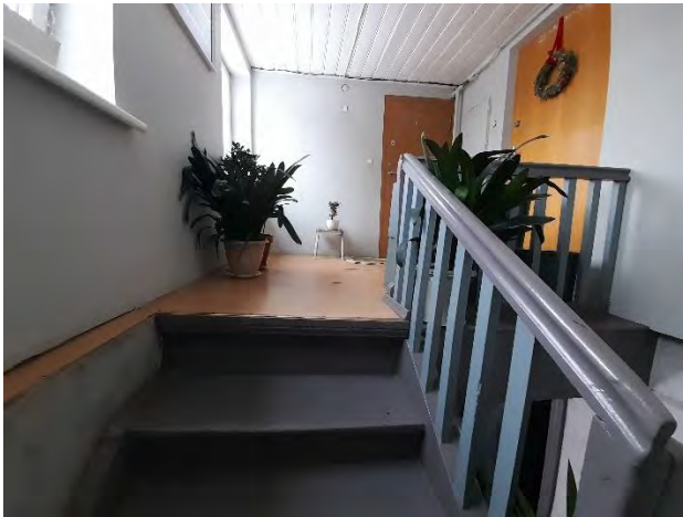
6 pav. Laiptinės vidaus apdaila atnaujinta, nuo buvusio pratekėjimo pažeistos lubų medinės dailylentės.
