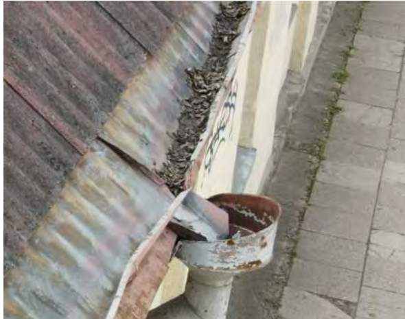
9 pav. Lietaus nuvedimo latakai pažeisti korozijos, jų sujungimo vietos nesandarios. Deformuoti, nesandarūs lietvamzdžiai.
