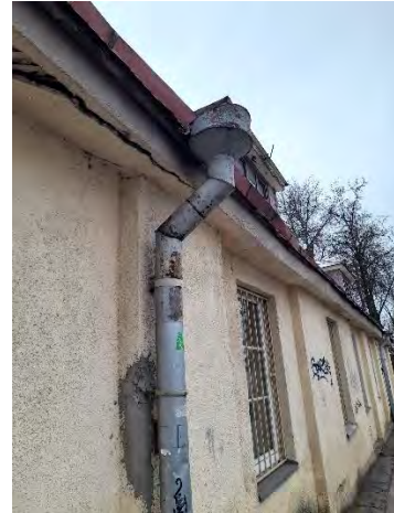
9 pav. Lietaus nuvedimo latakai pažeisti korozijos, jų sujungimo vietos nesandarios. Deformuoti, nesandarūs lietvamzdžiai.
