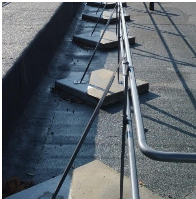
Principinis tvorelės įrengimo variantas, nepažeidžiant stogo dangos.
