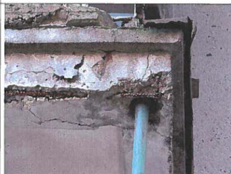
Pav. 14 Tas pats, dešiniojo supleišėjusio mazgo su atvira išilginės briaunos armatūra.
