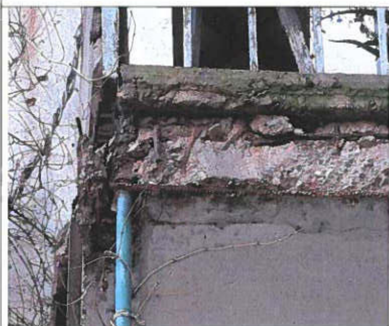
Pav. 12 30-jo, avarinio balkono (12.butas) kairiojo pakabos mazgo, paremto metalinio vamzdžiu, vaizdas.
