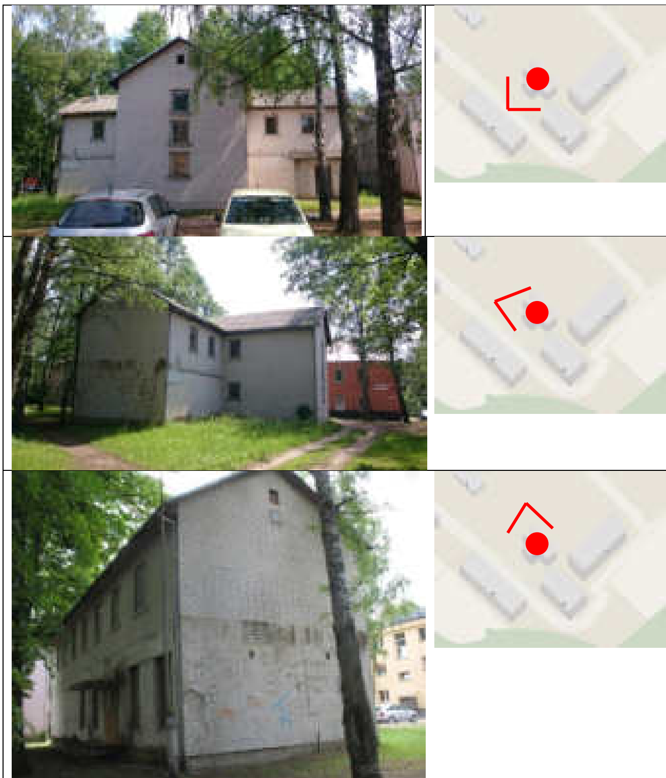
Rekonstruojamas pastatas. Vytenio g. 12
