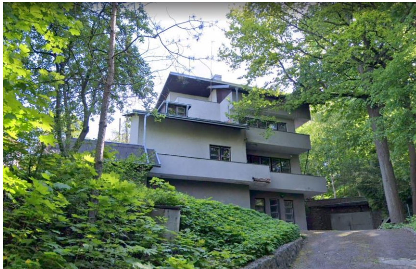
Pav. Esamos situacijos fotofiksacija
