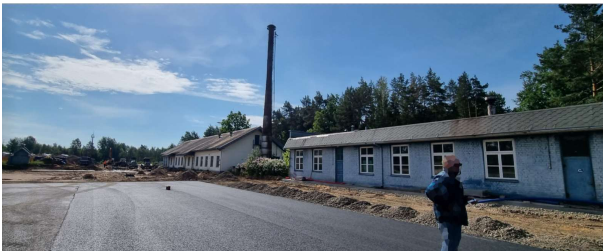
2 pav. Esamos situacijos fotofiksacija
