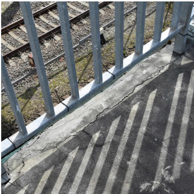
22 pav. Išilginiai plyšiai tarpinės aikštelės kraštuose.
