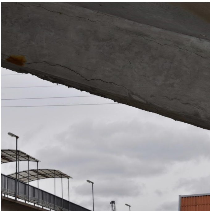
16 pav. Išilginiai plyšiai laiptasijoje.
