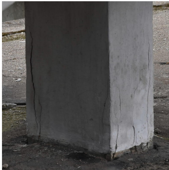
15 pav. Išilginiai plyšiai kolonos apatinėje dalyje.
