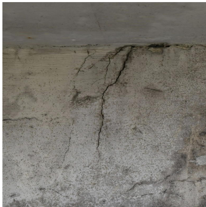
17 pav. Normaliniai plyšiai laiptasijoje.
