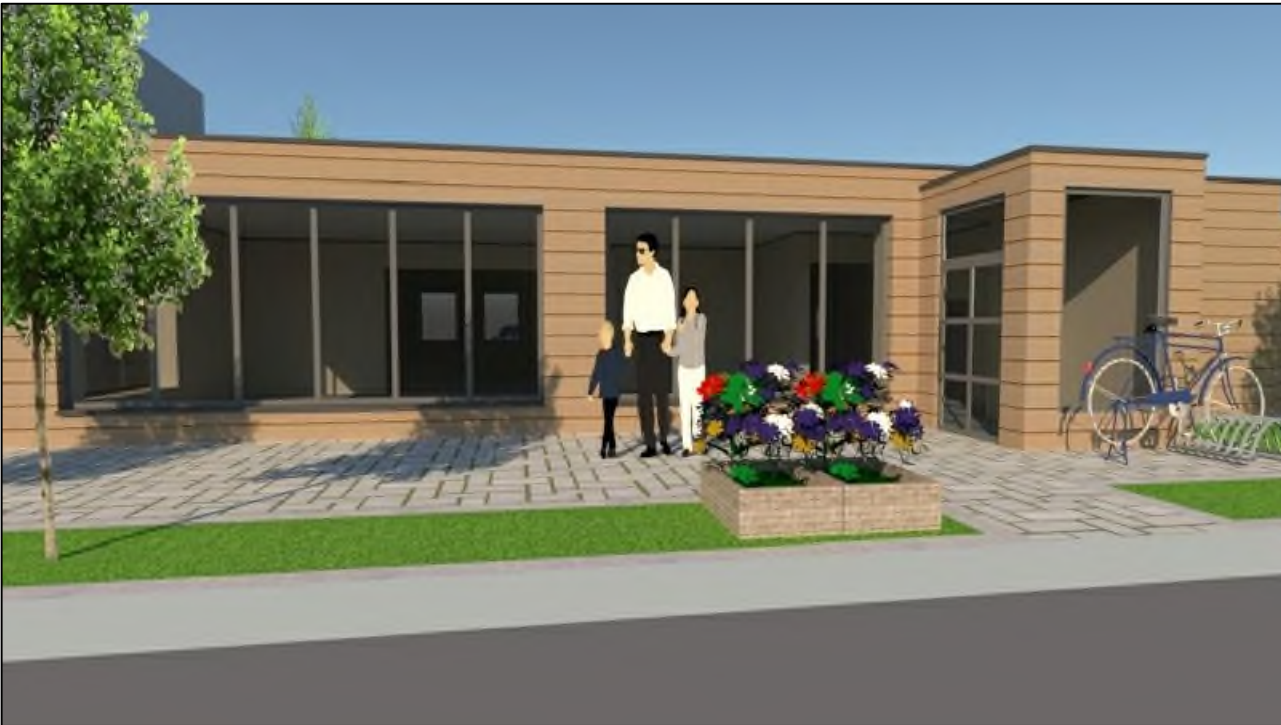
- Ventiliuojamas fasadas, apdaila termomedienu.
