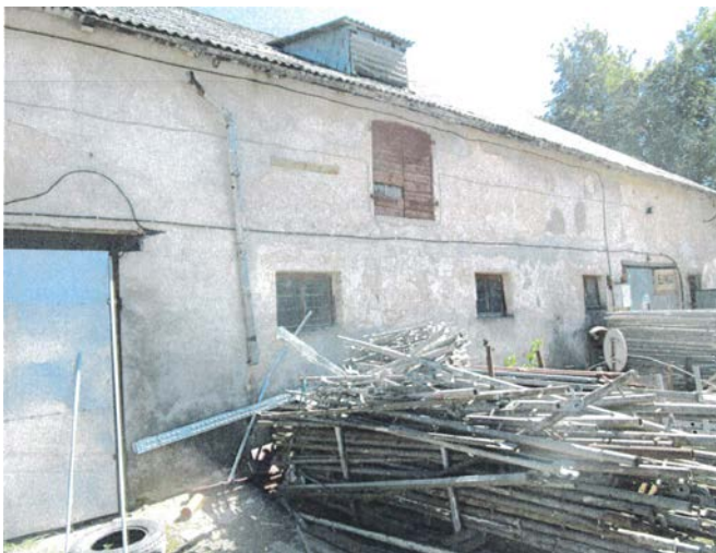
Pav. 5 Autentiškos sienos fragmentas su iškirstomis angomis apatiniame lygyje ir autentiškomis angomis ertikio lygyje.
