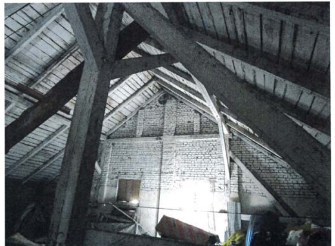
Pav. 6 Galinė siena ašyje „6“, vaizdas iš vidaus. Siena 1 pl. storio su \frac{1}{2} plytos piliastrais. Apatinė dalis tinkuota, langai be sąramų – iškirsti.
