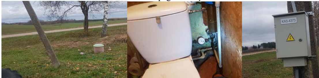
6,7,8 pav. gyvenamojo namo išgrėbimo duobės vieta, vandentiekio skaitiklis, aptarnaujama UAB Kelmės vandenys elektros apskaita ant oro linijos atramos
