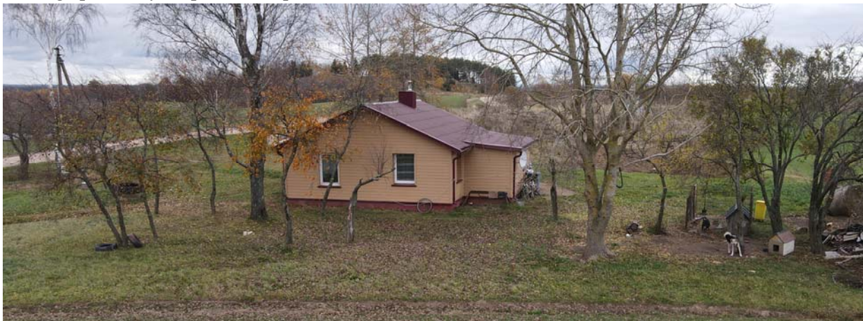
10 pav. rekonstruojamas pastatas
