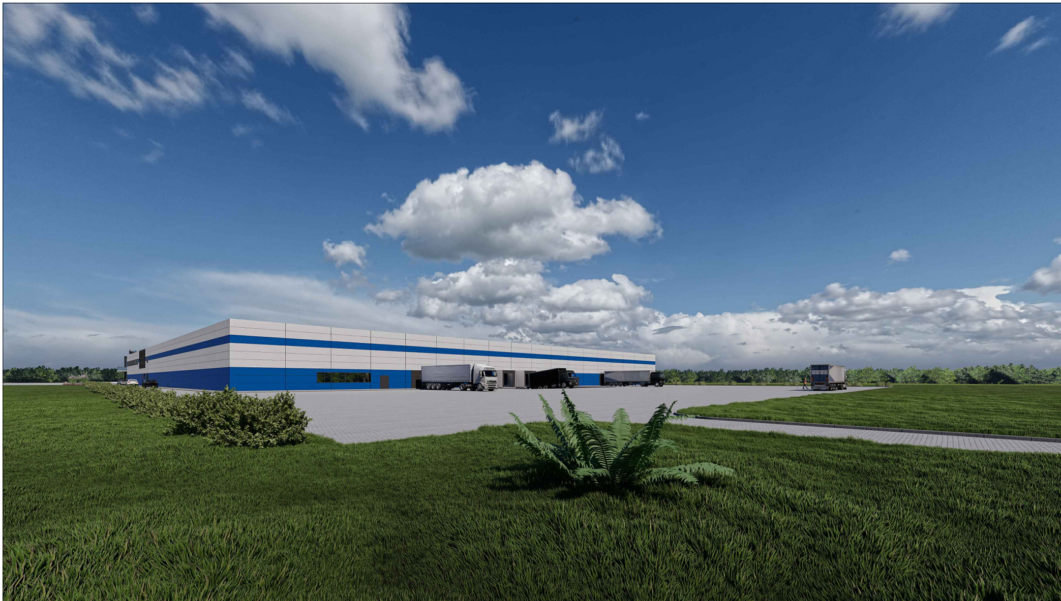
6 paveikslas. Rytinės pusės vaizdas - pakrovimo rampos.
