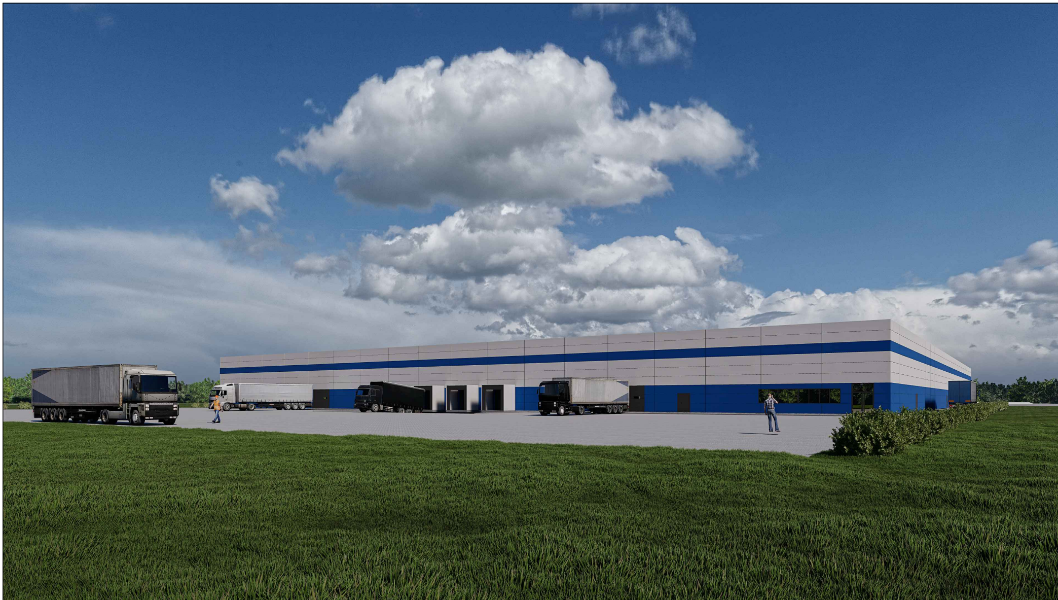
7 paveikslas. Šiaurinės pusės vaizdas - pakrovimo rampos.
