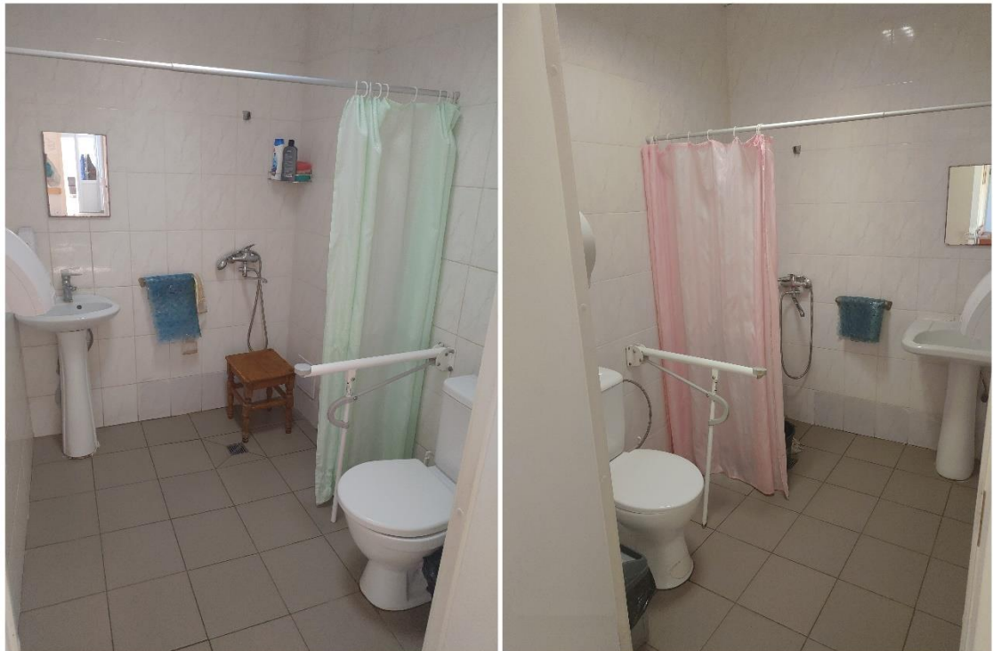
2. pav. san. mazgų pritaikytų neįgaliesiems faktinės būklės foto fikscija
