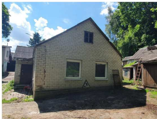
Šiaurės Vakarų fasadas
