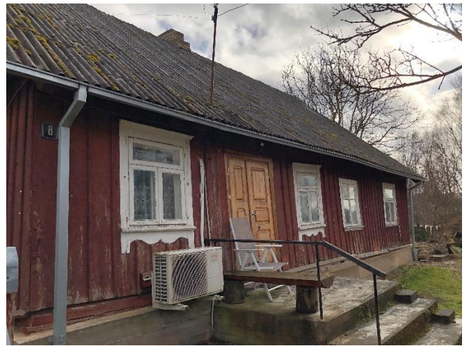
pav. Fasadas nuo A. Ažubalio g. (šiaurės vakarų pusės)
