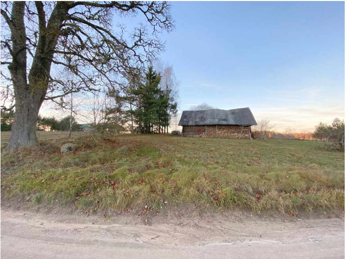
Esamas ūkio pastats – rekonstruojamas
