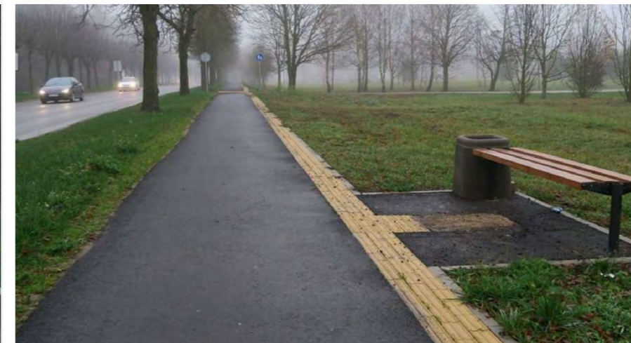
Pėsčiųjų takas su asfaltbetonio danga pritaikytas ŽN
