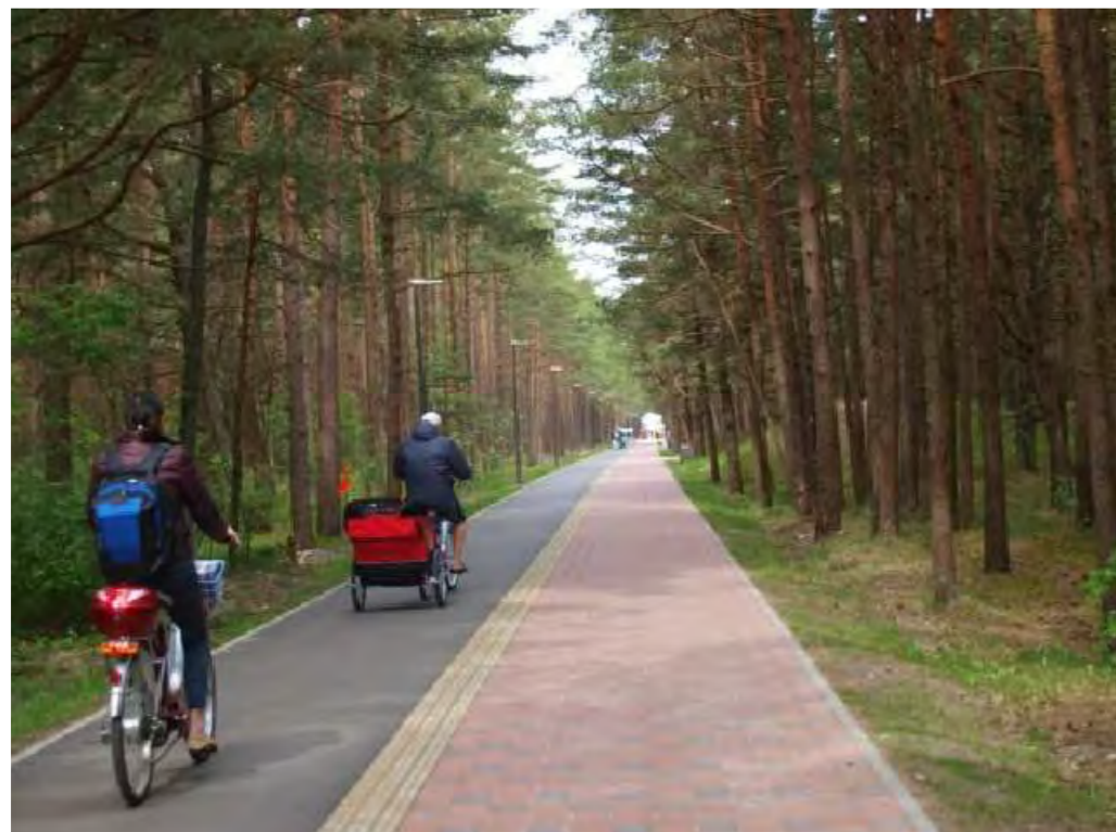
Asfaltbetonio dangos dviračių juosta su trinkelio dangos pėsčiųjų taku
