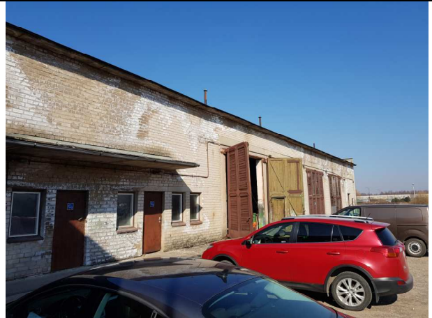
Pastato rytinis fasadas.
