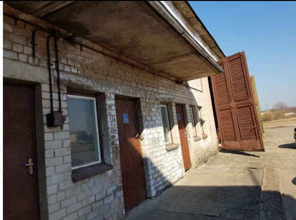
Pastato rytinis fasadas.
