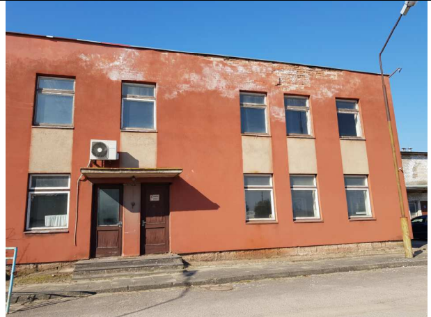
Pastato rytinis fasadas.
