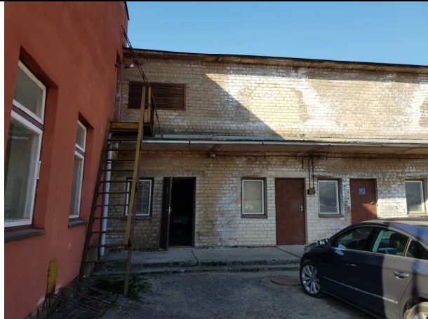
Pastato rytinis fasadas.
