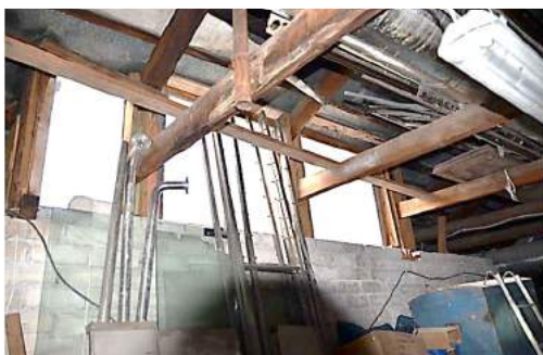
Stoglangio virš laiptinės, ant silikatinių plytų sienučių viršus
