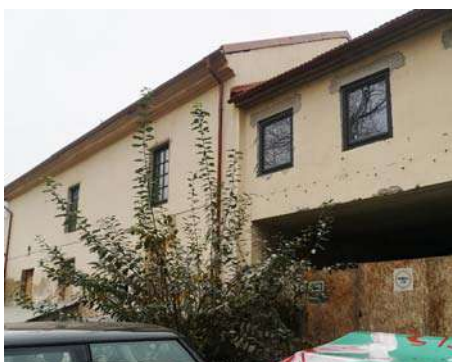
19 pav. Pastato Nr. 4 lauko fotografacija
