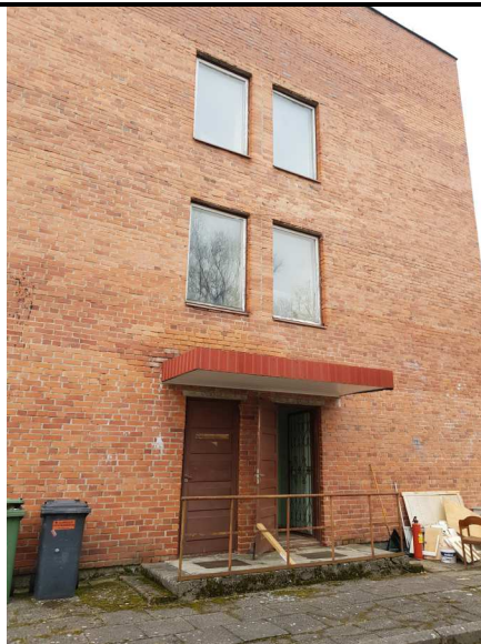
Pastato rytinis fasadas.
