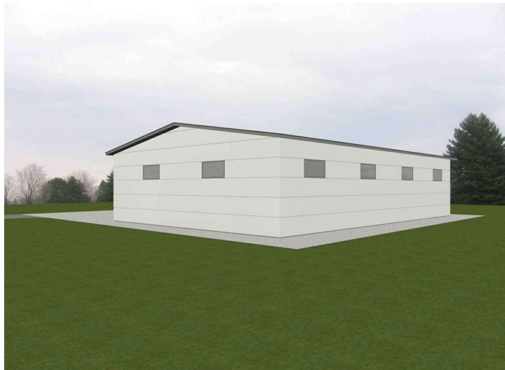
PASLAUGŲ PASKIRTIES PASTATO FASADAS IŠ PIETINĖS PUSĖS
