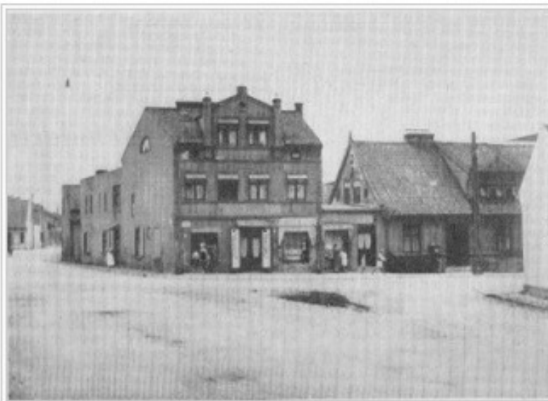
Schlewiesstr.20 (Memeler Dampfboot)
