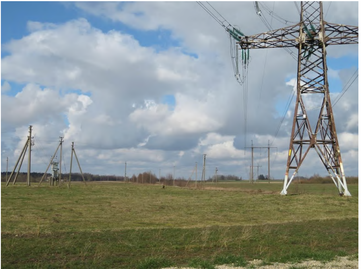
17 pav. Fotofiksacija nuo kelio Pagėgiai – Natiškiai (nr. 4201). Matomos aukštos (330 kV) ir žemos įtampos orinės elektros perdavimo linijos
