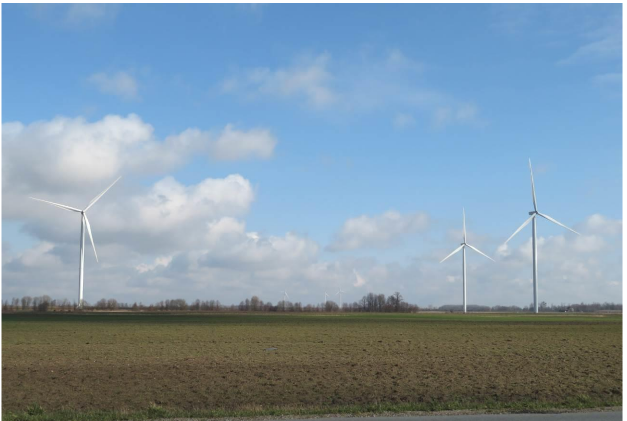
6 pav. Fotofiksacija nuo kelio Šilutė – Pagėgiai (nr. 141). Artimojoje ir tolimojoje perspektyvoje matomos pastatytos vėjo elektrinės. Projektuojamos elektrinės bus statomos toliau už dabar esamas
