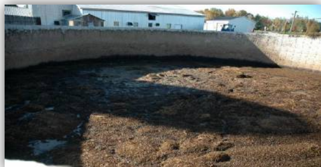
Gülesilo des Betriebs
