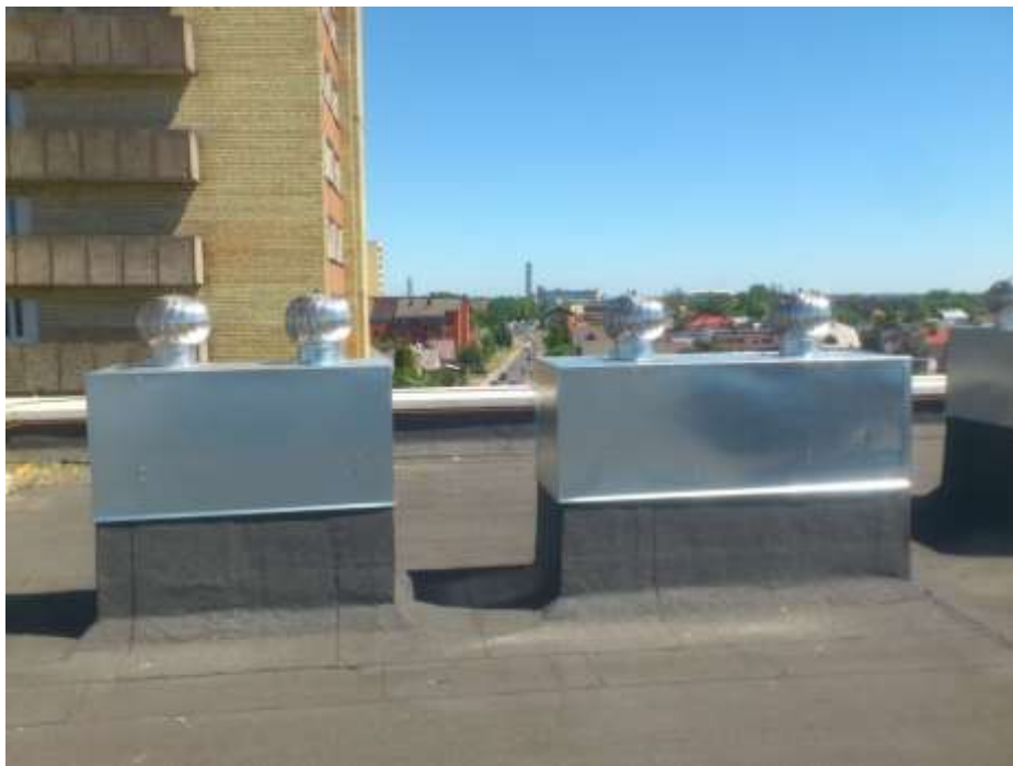
1 pav. Vėjo turbinų ir apjungimo kolektorių įrengimo pavyzdys.
