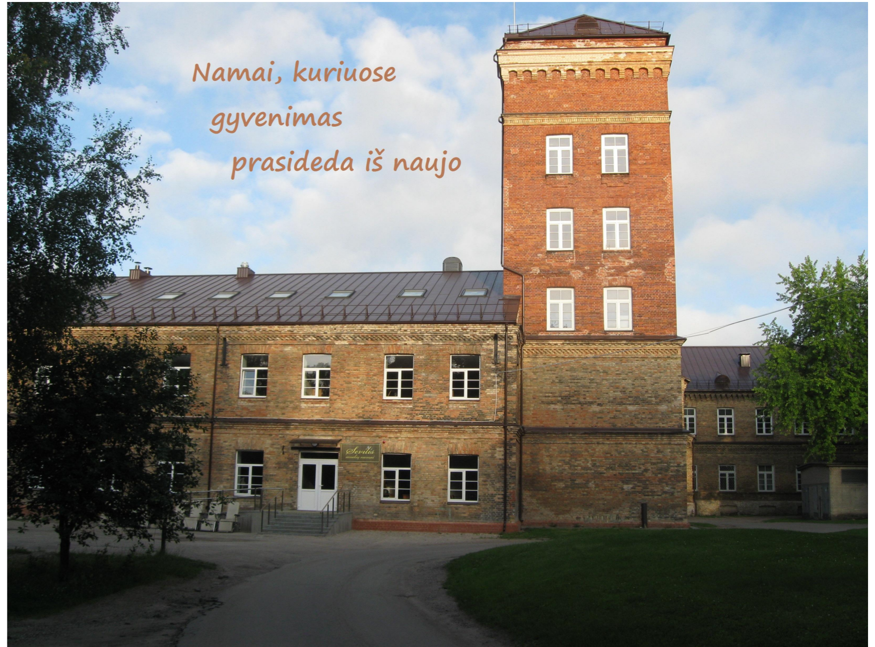
PLANUOJAMŲ ĮRENGIMO DARBŲ PAVYZDYS - STOGLANGIŲ ĮRENGIMAS NUOTRAUKA ĮRENGTOS PASTOGĖS DALIES
