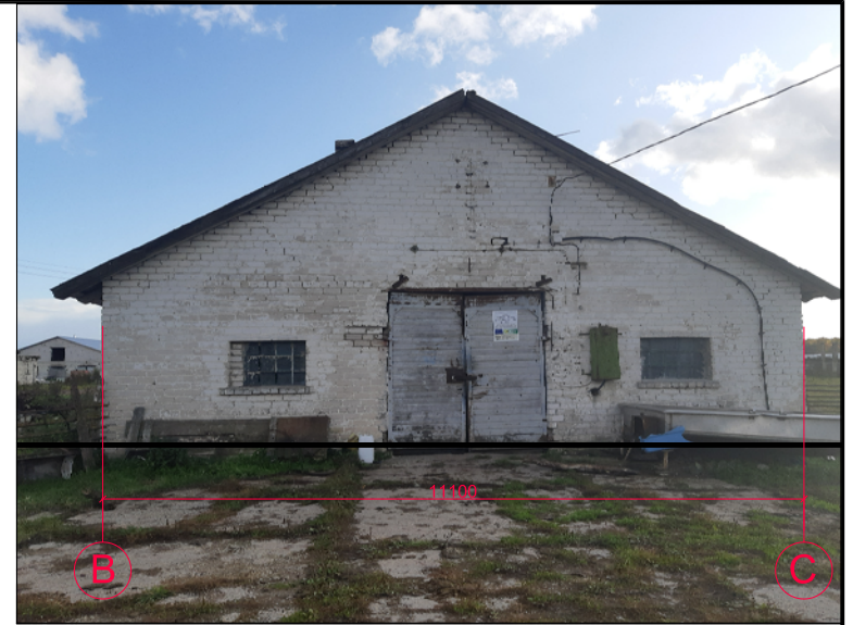
Rekonstruojamas pastatas "prieš"
