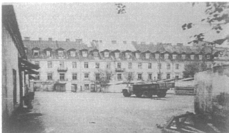
Paveikslas Nr. 2. Klaipėdos g. 7, Vilnius. Palėpių ir stoglangių įrengimo Vilniaus senamiesčio pastatuose rekomendacijų priedas nr. 5.
