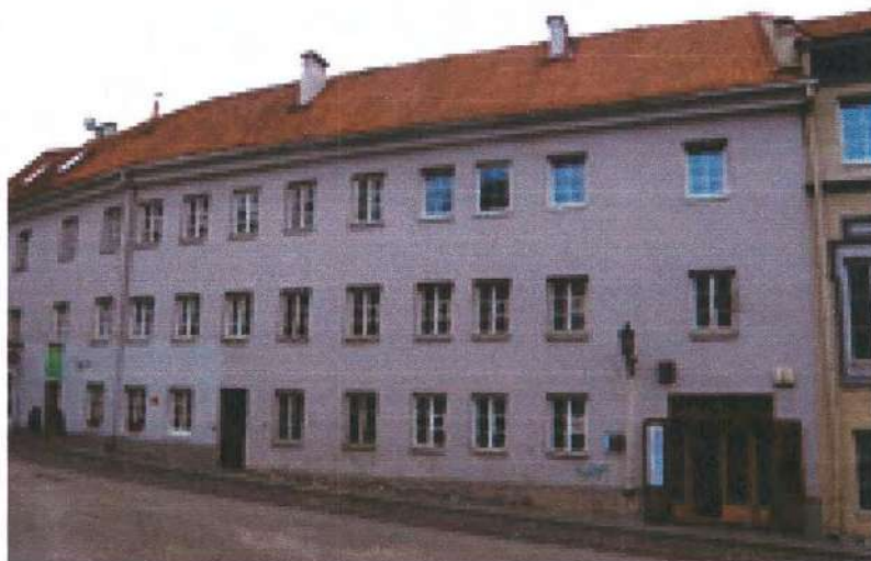
F 1 Dominikonų g. 15 pietų-rytų pastato Gaono g. fasadas
