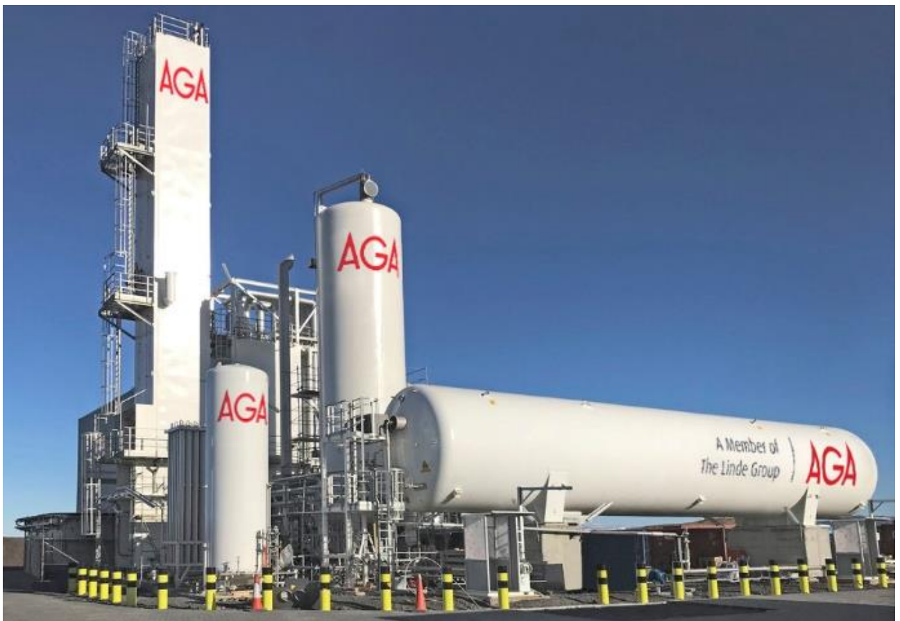
Pav. 1. AB „AGA“ skysto deguonies ir skysto azoto gamybos įrenginiai
