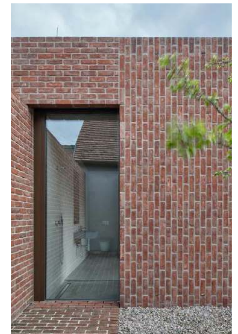
Fasadų apdaila - skirtingomis kryptimis dengiamos klinkerinės plytos (rausvi,molio,pilki atspalviai)
