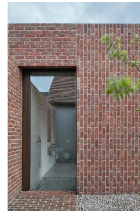
Fasadų apdaila - skirtingomis kryptimis dengiamos klinkerinės plytos (rausvi,molio,pilki atspalviai)
