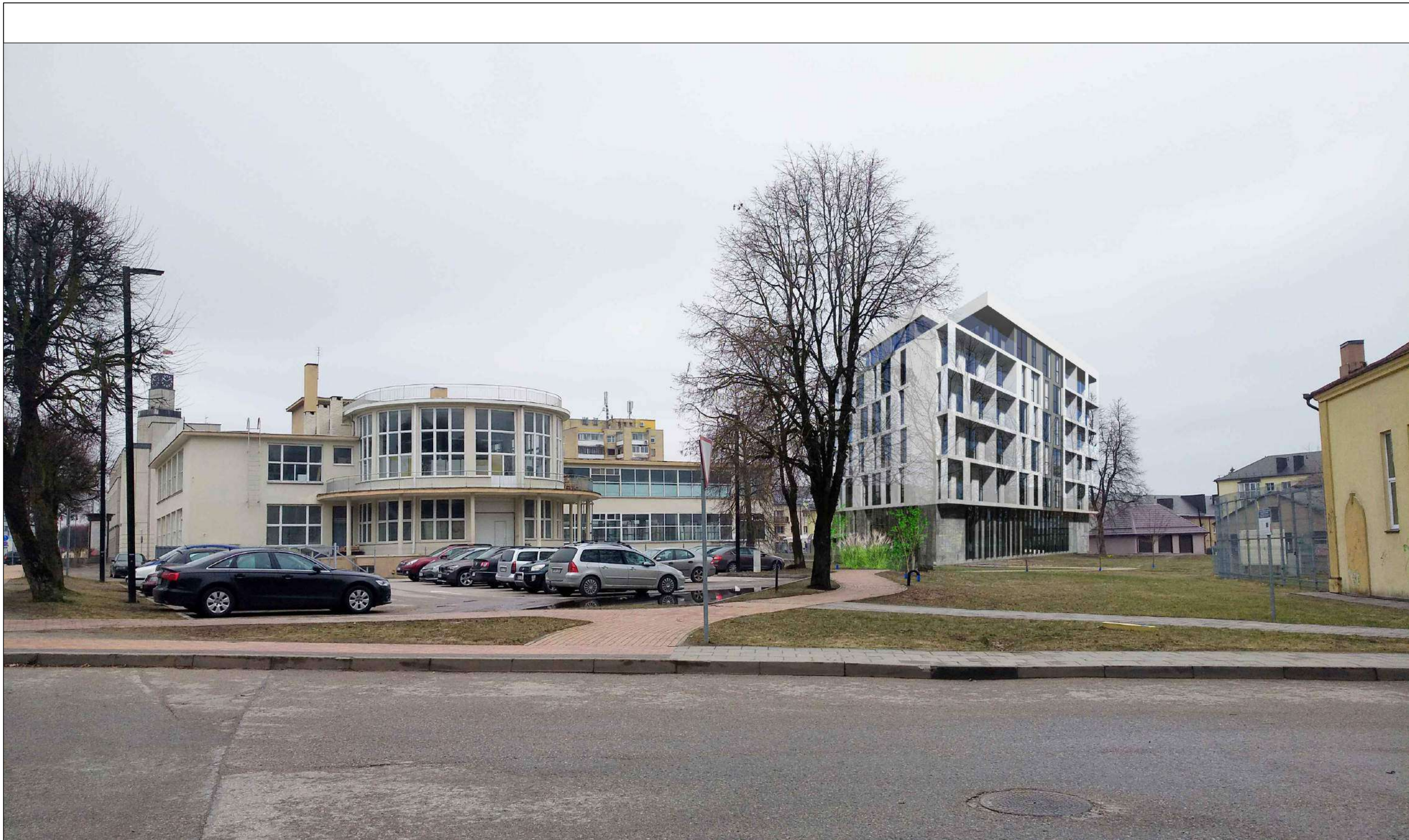
Prekybos paskirties pastato S. Dariaus ir S. Girėno g. 9 Alytuje statybos projektas PROJEKTINIAI PASIŪLYMAI
