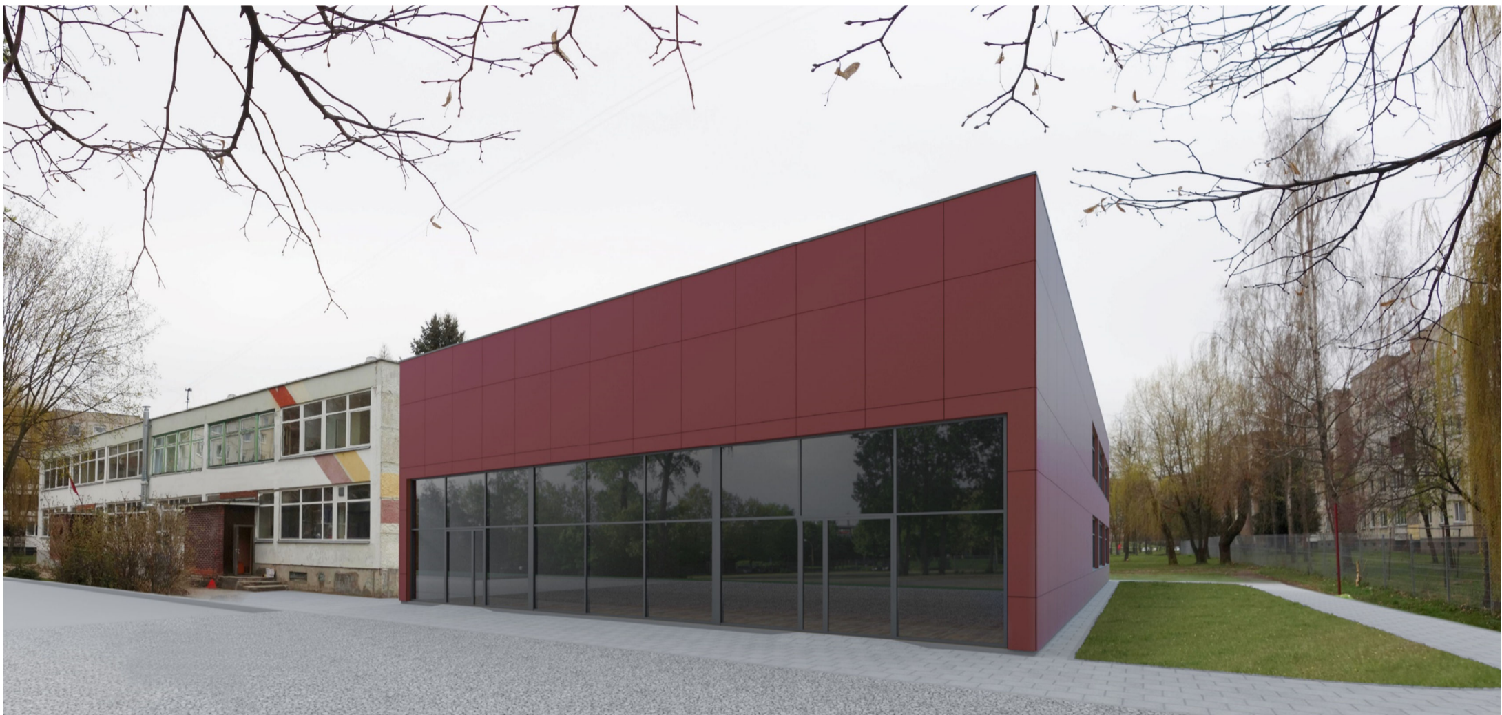
VAIZDAS Į NAUJĄ PRIESTATĄ IŠ ŠV (ŠIAURĖS VAKARAI) SKLYPO DALIES
